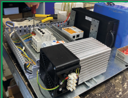
СБОРКА ЩИТОВОГО ОБОРУДОВАНИЯ
